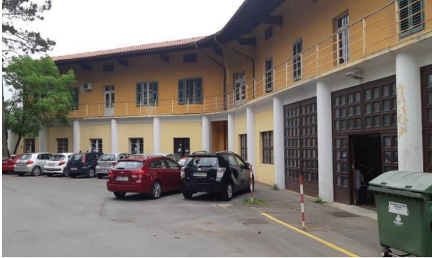
DELAVNICE IN MIKROBIOLOŠKI LABORATORIJ
