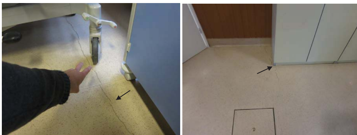
Slika 24: Razpoke v talni plošči
